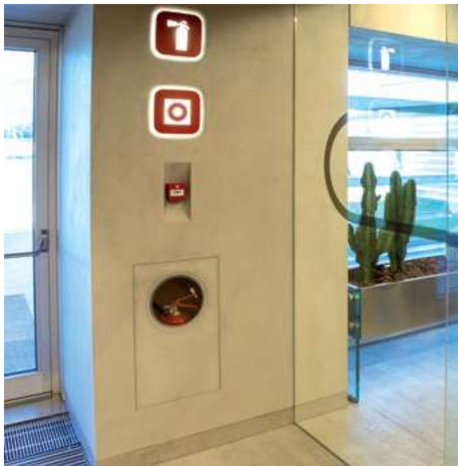
[ 1 ] Fantasmio anta in MDF con lavorazione per inserimento oblò in cristallo. Fantasmio with MDF door with slots for inserting glass porthole.
