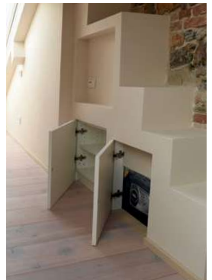
Fantasmino un'anta in MDF per chiusura nicchia apertura verticale per nascondere piccola cassaforte. A fianco Box ad un'anta completo di contenitore per piccolo ripostiglio.
