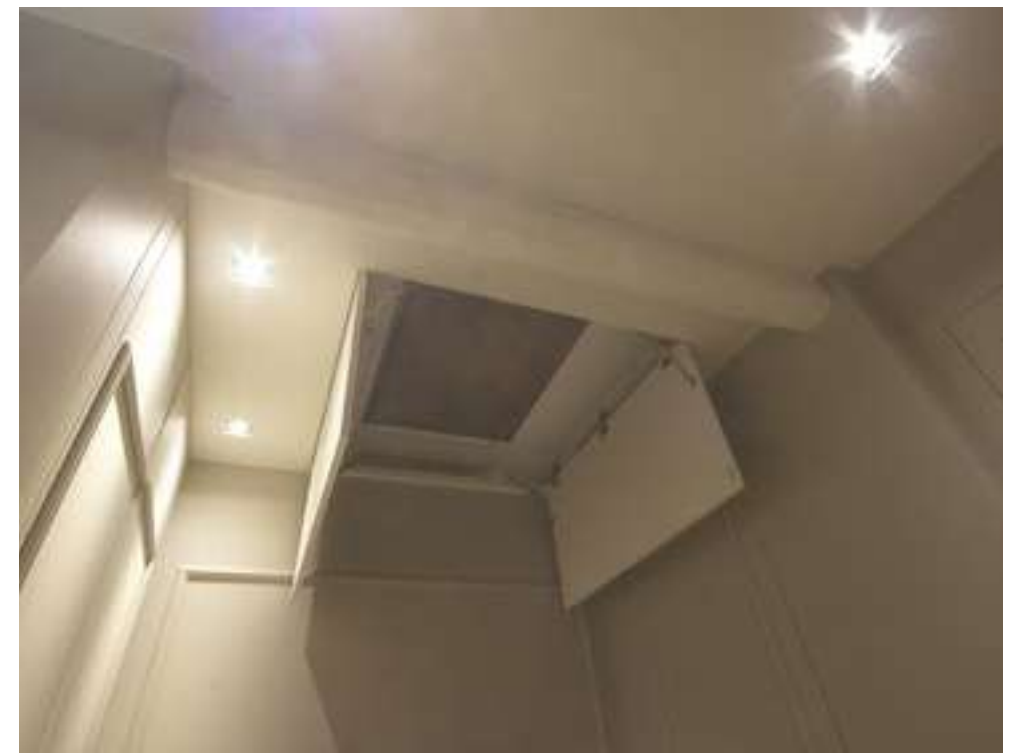
Botola Fantasmio a due ante in MDF complete di bracci stabilizzatori.
